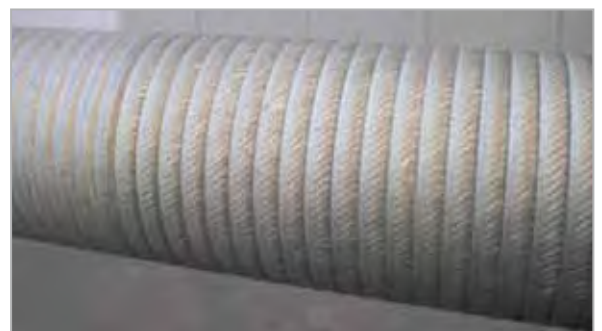
Сварка перед обработкой поверхности Welded surface before machining
