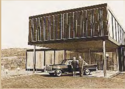
Errichtung des neuen Wohnhauses 1960
