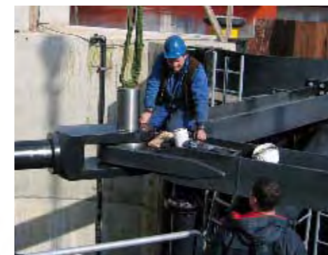
Hydraulische Systemlösung zum Antrieb und zur Steuerung der Drehsektortore der Schleuse Neuer Hafen in Bremerhaven – von der Planung und Konstruktion bis zur Fertigung und Montage.
