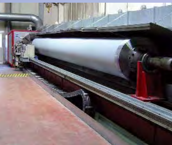
Beschichtungsanlage für keramische Metalloxid-Mehrstoffbeschichtung Ceraplate 2000
