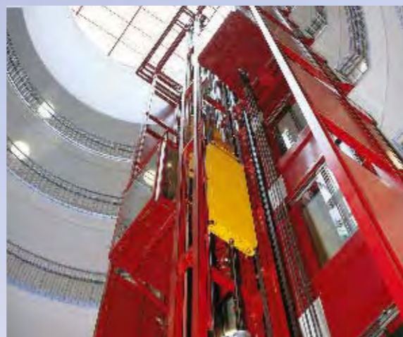
Hydraulikgestänge eines Glasaufzugs
