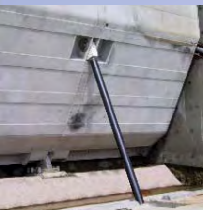
Hydraulikzylinder zur Klappenbetätigung am Lower Colorado River Staudamm
