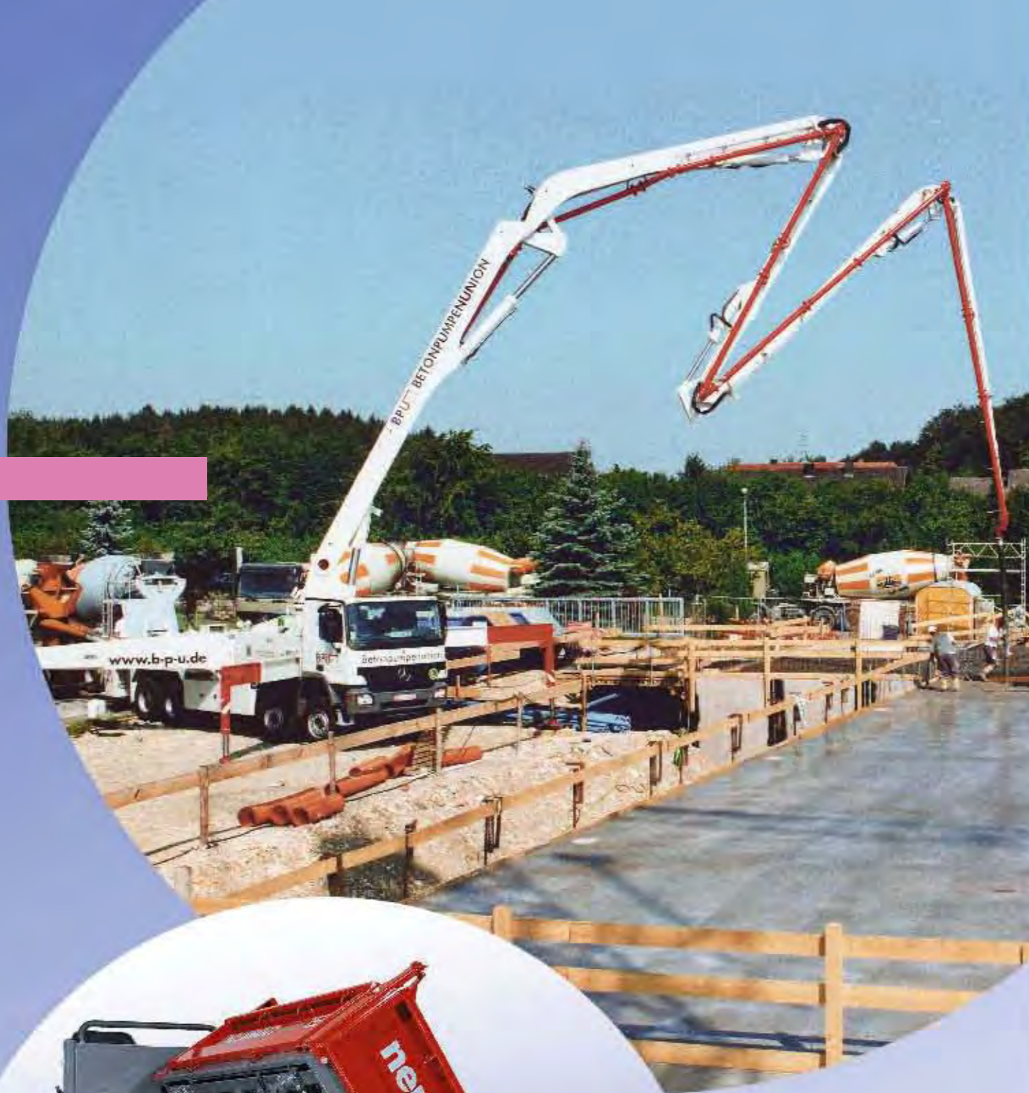
Betonpumpe M47 mit fünf hydraulischen Segmenten (Foto: Putzmeister)
