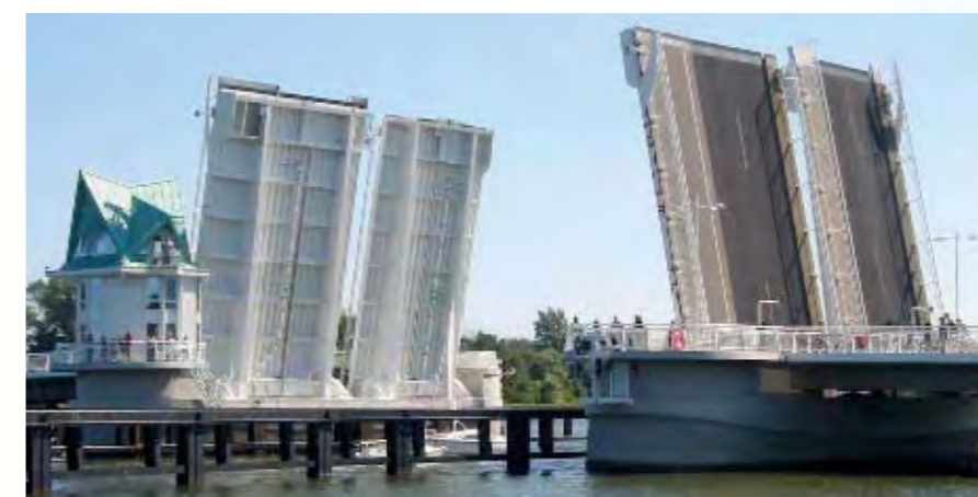
Neue Schlei-Brücke in Kappeln
