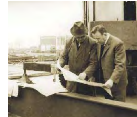
Baubesprechung der Fabrikerweiterung
