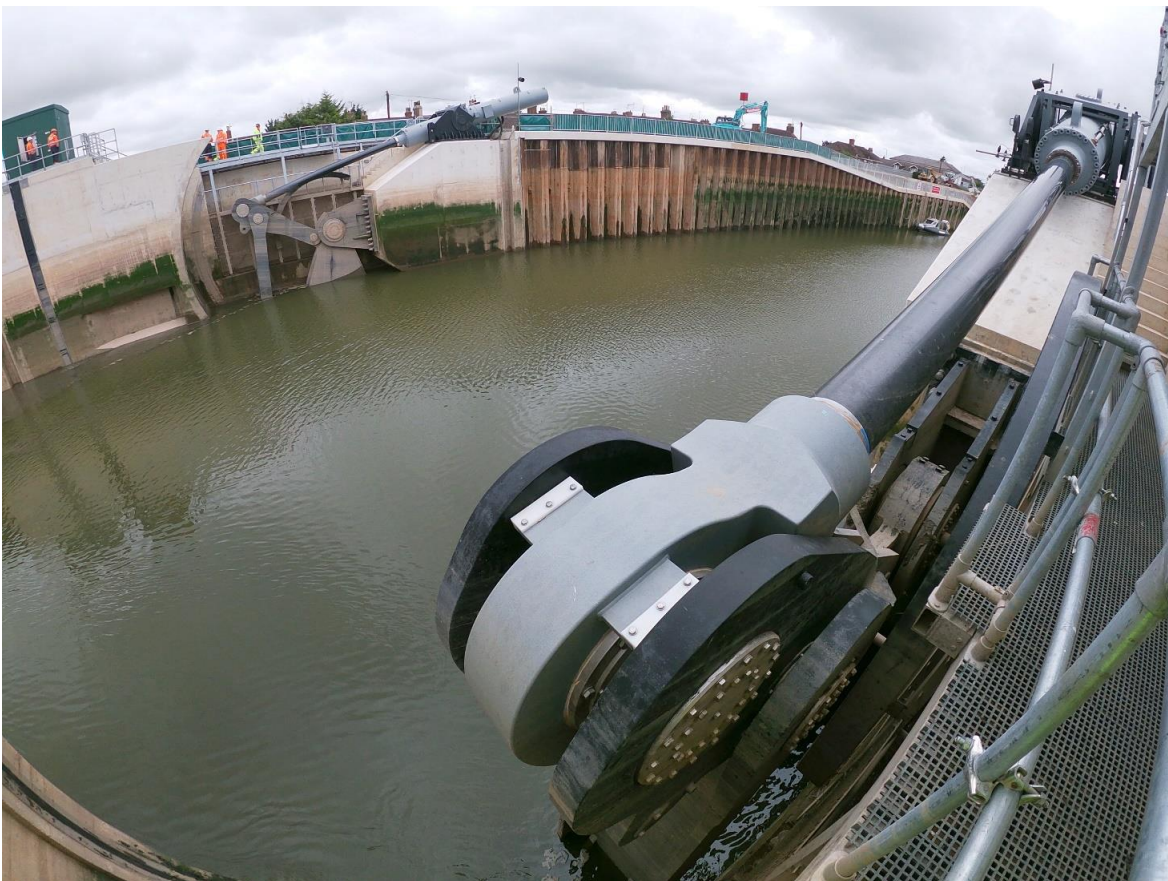
Hydraulikzylinder in geöffneter Torposition
