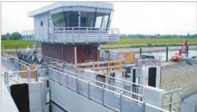
Горизонтальные раздвижные ворота шлюза в Татенберге с гидроцилиндром (длина хода 13 м ) Horizontal shift gate of ship lock Tatenberg with hydraulic cylinder with 13 m stroke
