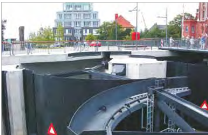
Судоходные шлюзы поворотных ворот и рычажных портов в Вильгельмсхафене
