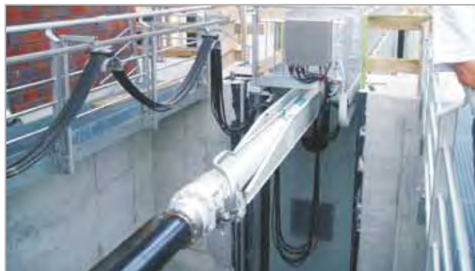
Горизонтальные раздвижные ворота шлюза в Татенберге с гидроцилиндром (длина хода 13 м ) Horizontal shift gate of ship lock Tatenberg with hydraulic cylinder with 13 m stroke
