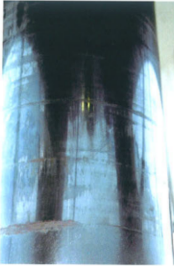
Bild 4: Spaltkorrosion an einer Metalloxidbeschichtung (Fotos: Hunger) Fig. 4: Crevice corrosion on a metal oxide coating (photographs: Hunger)
